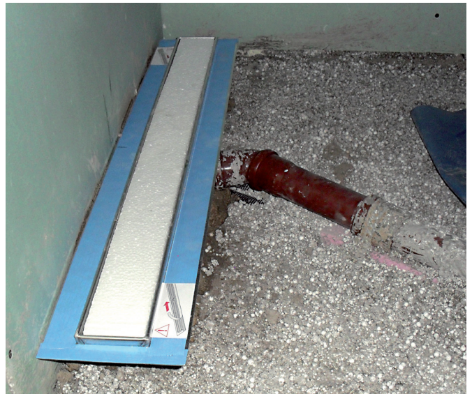
Abflussrohrmuffen verringern zusätzlich die Estrichdicke
