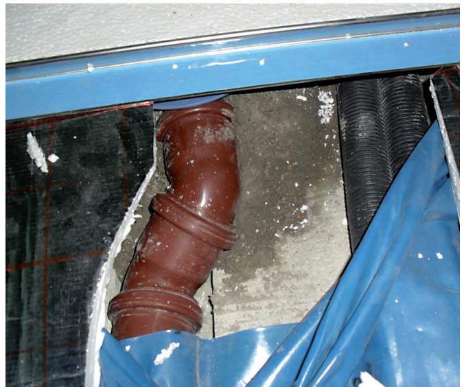
Horizontaler Abflussanschluss ohne Rücksicht auf den Fußbodenaufbau
