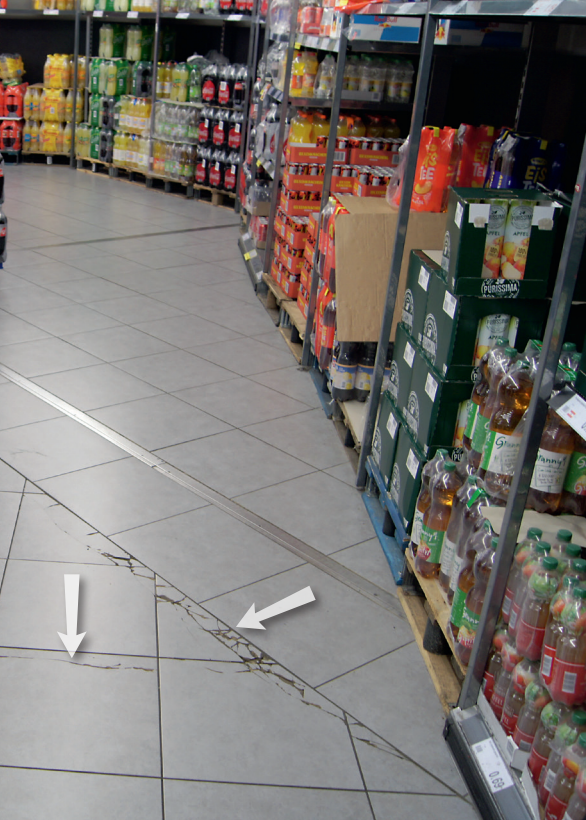
Detailansicht nach Entfernen des Fliesenbelages. Versetzte Fuge im Untergrund, Risse im Fliesenbelag.
