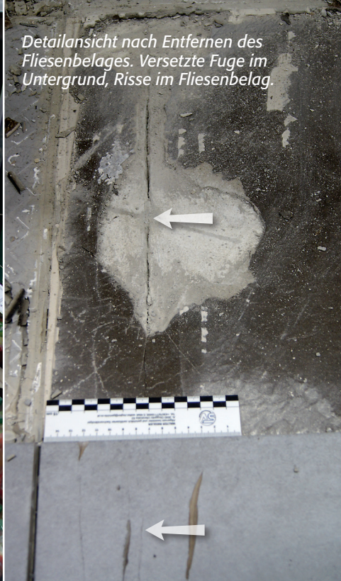
Vernähte Fuge der Betonplatte nach Entfernung des Fliesenbelages.
