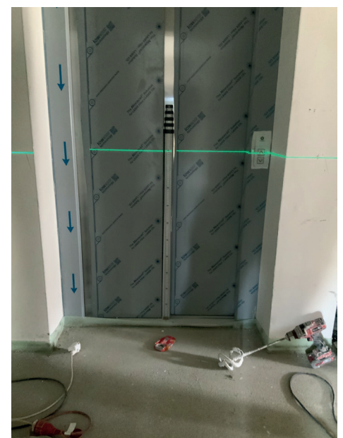
Kontrolle der Bodeneinstandsschiene des Aufzugs
