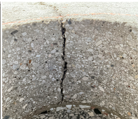
Durchgehender Riss bei einer Verbundkonstruktion
