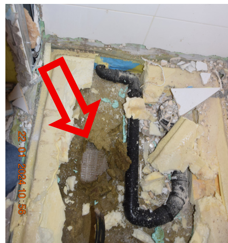
Feuchtigkeit unter dem Wannenträger
