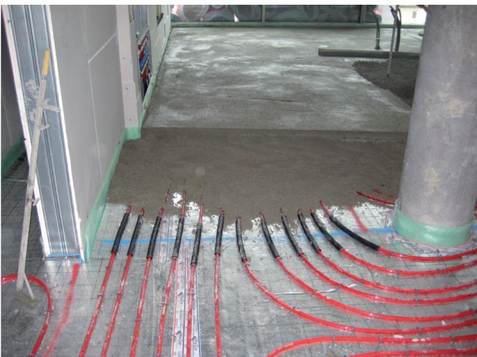
Abb. 1: Bei Installation der Heizungsleiter muss der Abstand der Rohre mindestens 10 – 12 cm sein.
