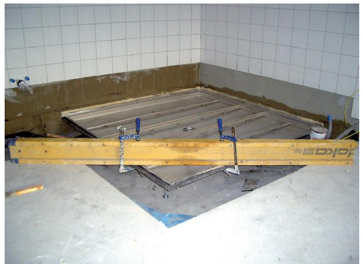
Abb. 2: Beim Einbau von Ausgusswannen in Großküchen ist die Zusammenarbeit von Installateur und Estrichhersteller unbedingt nötig.
