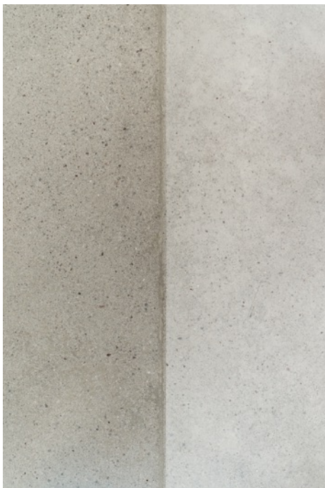
Abb. 26: Unterschied vor vs. nach der Versiegelung
