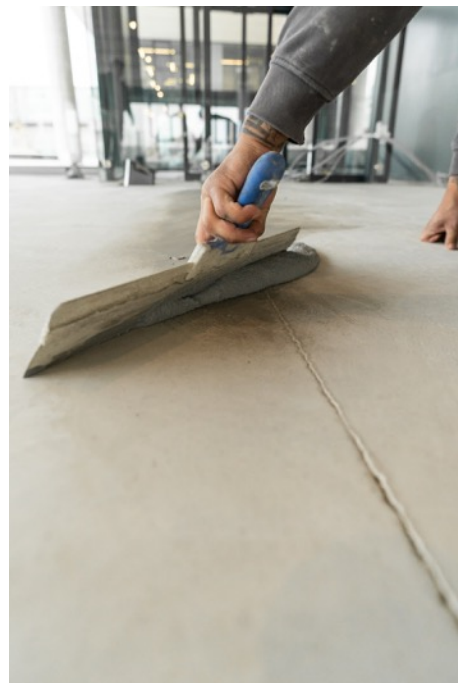
Abb. 15: Fugenverguss
