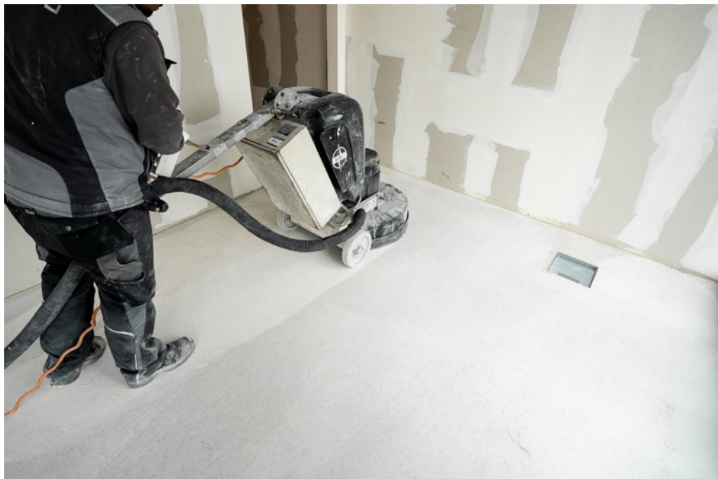
Abb. 3: Grobschliff/Diamantschliff
