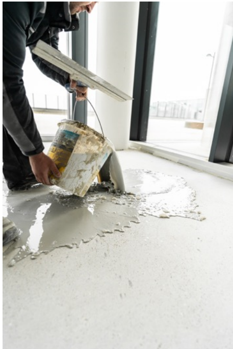
Abb. 13: 1. Lunkerspachtelung und Porenfüllung
