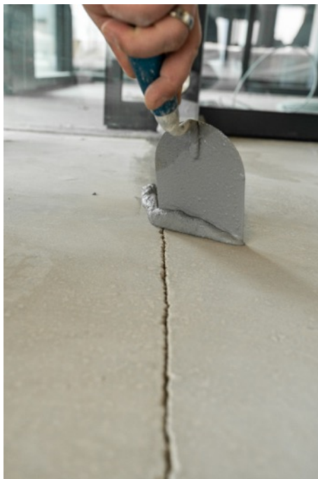
Abb. 14: Fugenverguss
