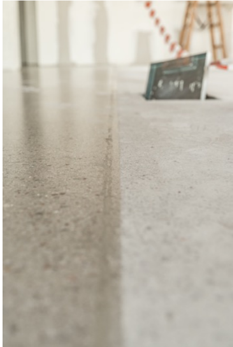
Abb. 25: Unterschied vor vs. nach der Versiegelung
