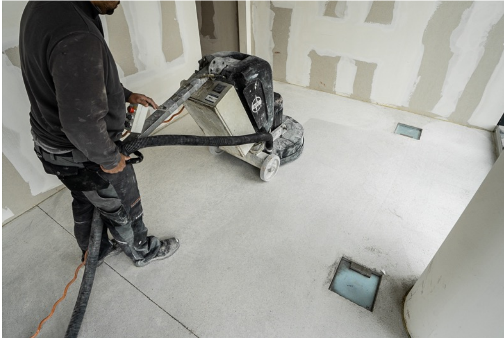
Abb. 7: Mittelschliff
