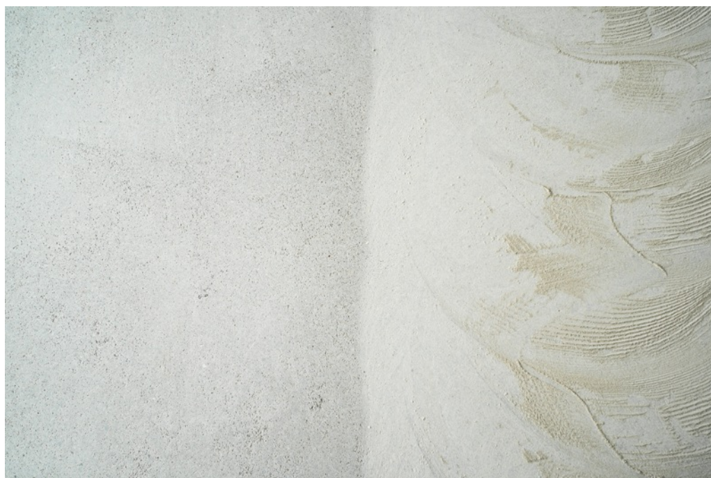
Abb. 4: Grobschliff/Diamantschliff
