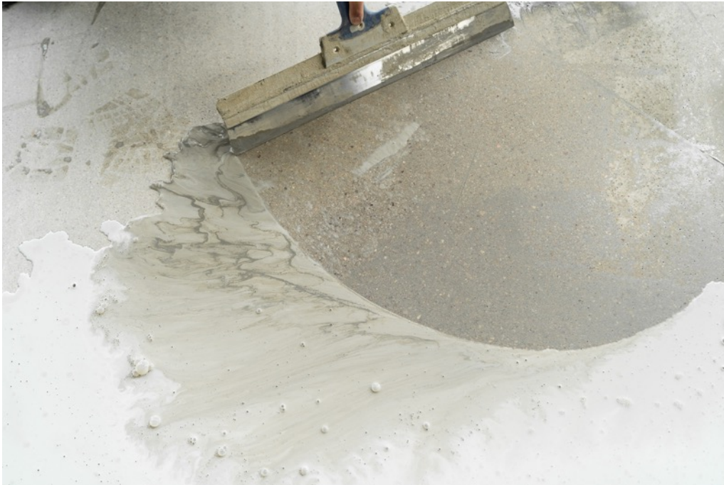
Abb. 11: 1. Lunkerspachtelung und Porenfüllung
