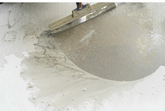
Abb. 11: 1. Lunkerspachtelung und Porenfüllung
