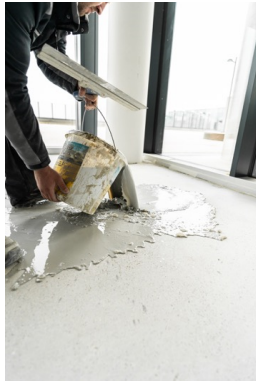
Abb. 13: 1. Lunkerspachtelung und Porenfüllung
