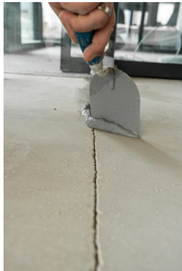
Abb. 14: Fugenverguss
