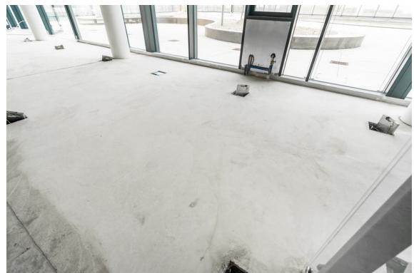
Abb. 12: 1. Lunkerspachtelung und Porenfüllung
