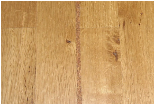
Abb. 10: Belagsfuge aus Kork in einem geklebten Parkettbelag
