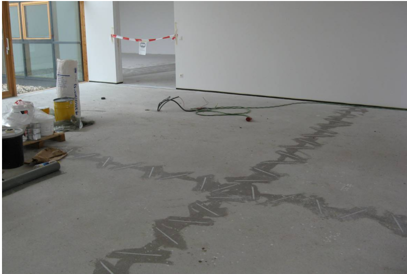
Abb. 4: Scheinfugen verdübelt
