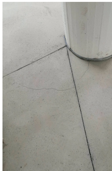
Abb. 3: ungünstige Anordnung führt zur Rissbildung
